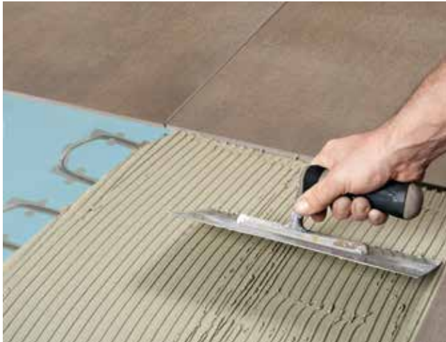
Genial: Elektroheizung im Kleberbett · Brilliant: electric heating in an adhesive bed · Ingénieux : chauffage électrique dans un lit de colle
