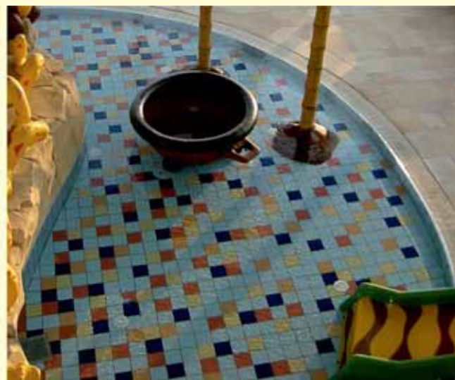
Детский бассейн в ярком исполнении, плитка с анискользящей поверхностью «С»
